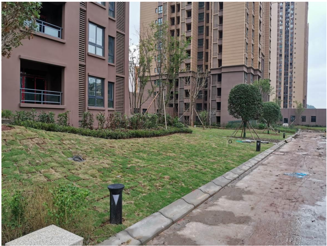
3#楼南侧绿化工程（2019年10月）
