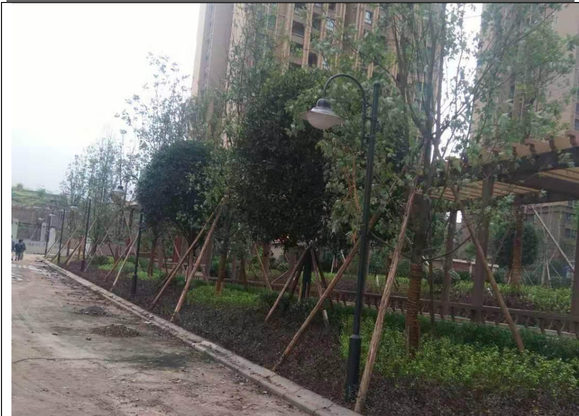
5#楼北侧绿化工程（2019年10月）
