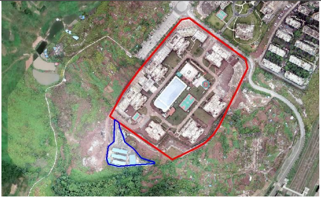
图4.5 项目竣工后扰动地表情况（2019年10月，无人机影像）
