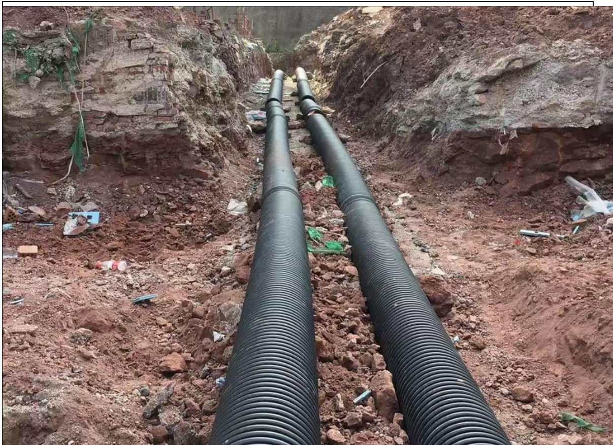
6#楼南侧雨水管网（施工单位提供）
