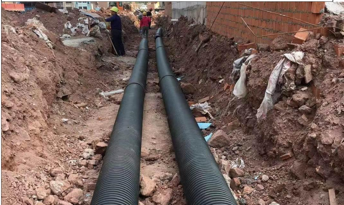
2#楼西侧雨水管网（施工单位提供）
